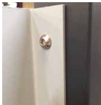
Panneau fixé sur poteau avec écrou
